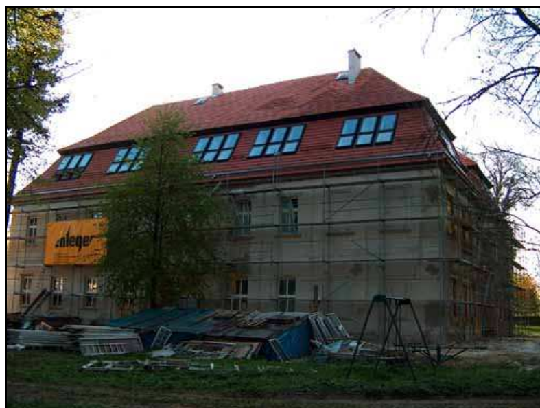
foto. 3. Pałac w Tuszynie w czasie prac remontowych i adaptacji na budynek szkoły materiały z http://dolnyslask.org
